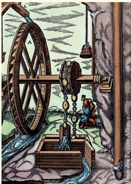
Beberwerk: Mit an einer Kette befestigten Ledertaschen holte man im Mittelalter das Wasser aus den Bergwerksschächten.
